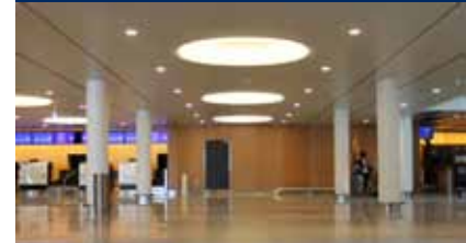
Loftspanelerne er klikket på og kan demonteres af én mand
