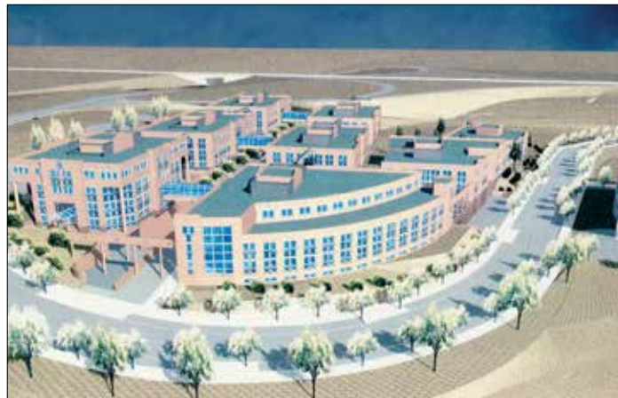
Euro net Office Park, 25.000 m 2 . Luxemburg/Munschbach, Baumeisterhaus Luxembourg.
